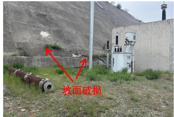
照片 3.2-11 P1 升压站南侧不稳定斜坡（镜向：280°） 照片 3.2-12 不稳定斜坡 P1 坡面破损（镜向：280°）
