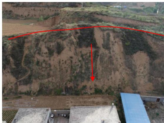
照片 3.2-3 HP1 滑坡局部滑塌 (镜向: 270°)
