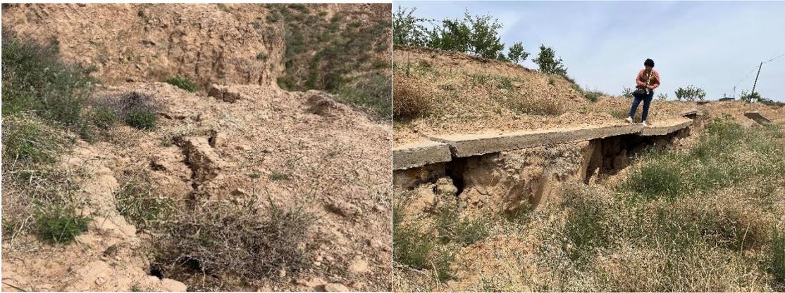
照片 3.3-1、3.3-2 85214 工作面边缘重度损毁（镜向 NW）
