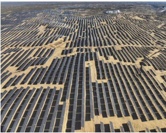
照片 2.6-4 隆武光伏发电项目 2
