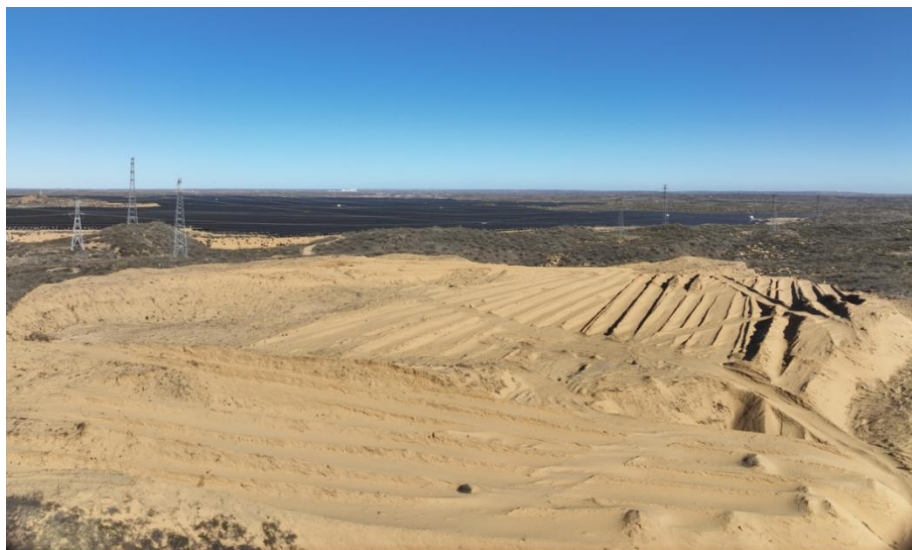
照片 1.3-8 北区风井场地总体现状
