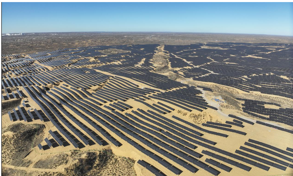
照片 2.6-5 北元新能源光伏发电项目 3
