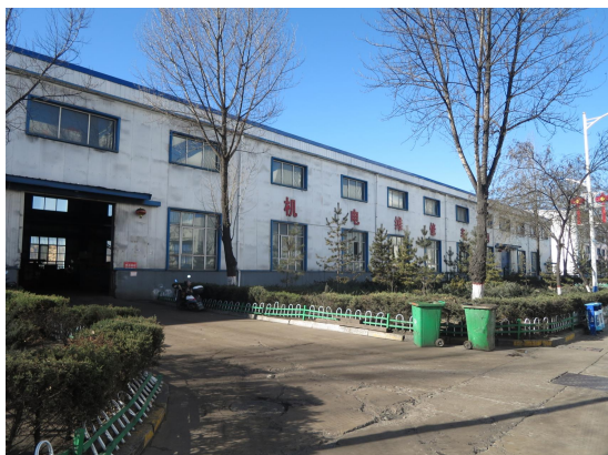
照片 1.3-4 机电维修车间（镜向：SW）
