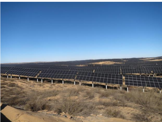
照片 3.2-4 北元新能源光伏项目（镜向 NE）
