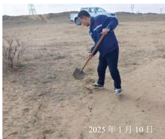
照片 1.5-5 黄土庙煤矿工作面裂缝充填（治理中）
