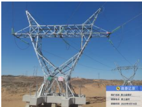
照片 1.5-1 远登线高压塔基加固
