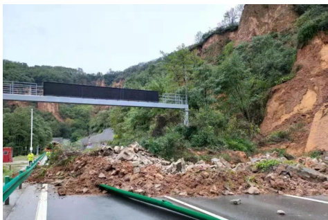
图5 晋城高速公路滑坡
