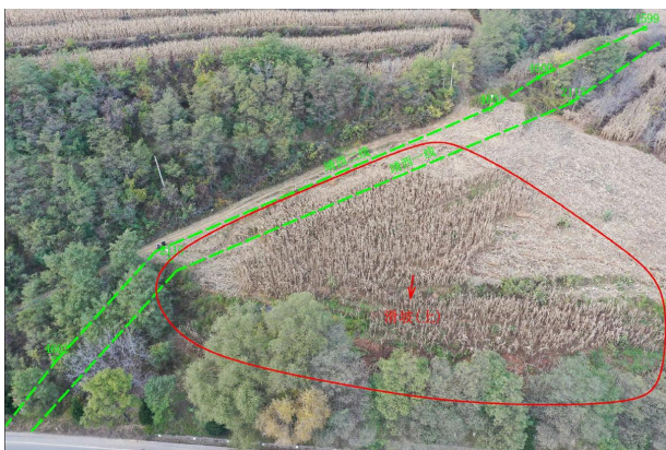
图7 天然气管道附近的滑坡
